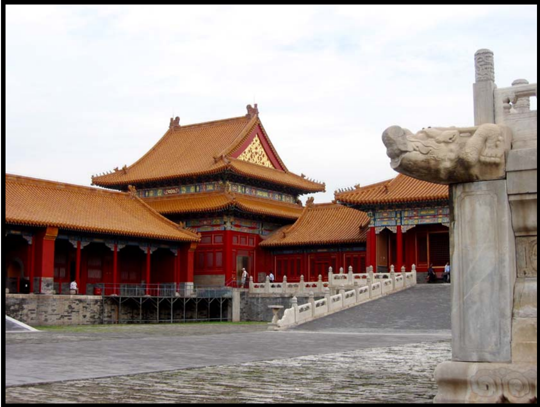
Bygningerne i Den Forbudte By er ved at blive sat flot i stand til næste års Olympiade
